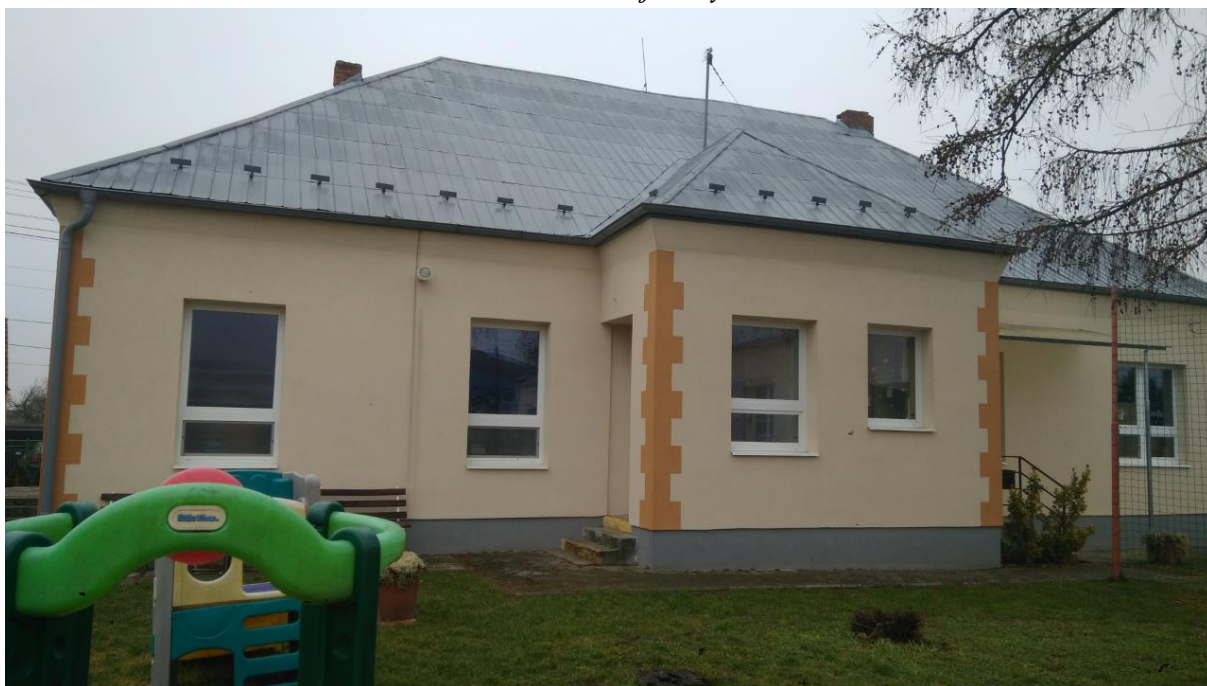
Obrázok č. 2 – Zrekonštruovaná budova materskej školy v obci
