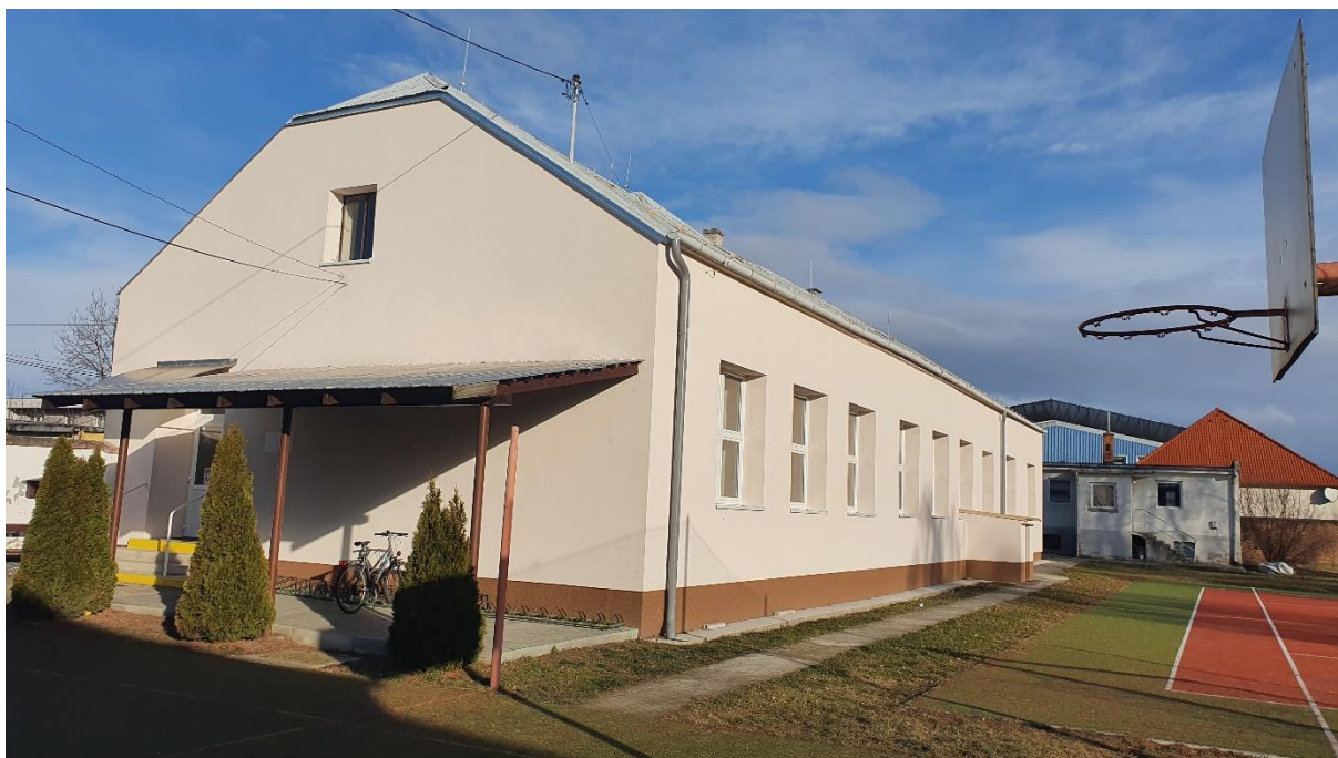
Obrázok č. 1 – Zrekonštruovaná budova základnej školy v obci
